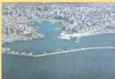
Αεροφωτογραφία του σημερινού λιμανιού της Ζέας
